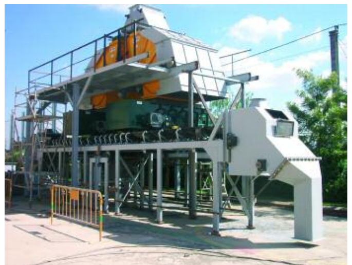
Estat actual dels garbells per a La Fou
