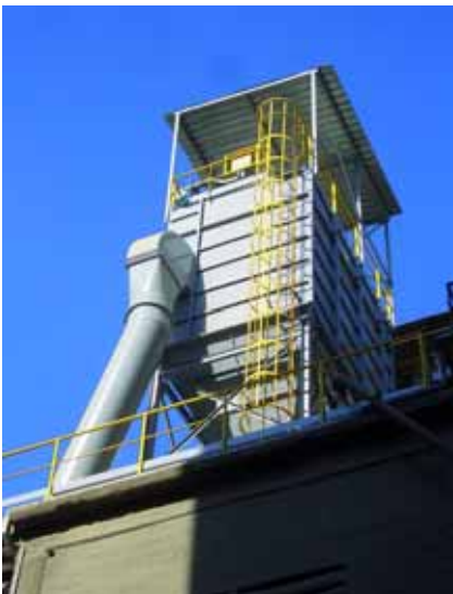
Nou filtre instal·lació de mólta 5C i 6C
